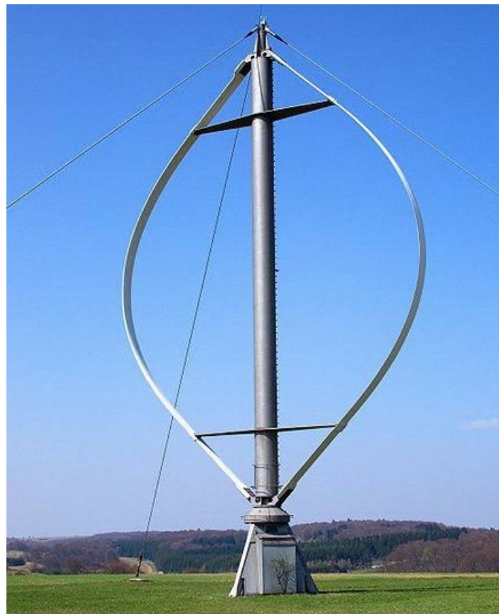
Figura 3. Aerogerador de eixo vertical. Fonte: HUCKEBER (2025).
