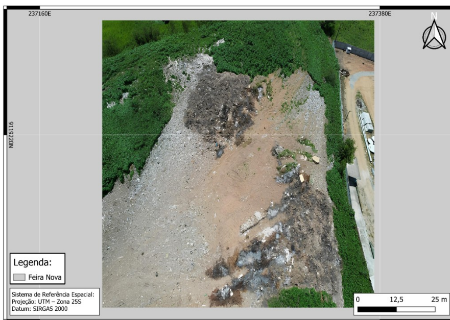
Imagem 03 - Área desativada de deposição dos resíduos sólidos
